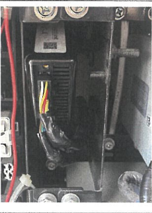
本体取付施工後周辺
