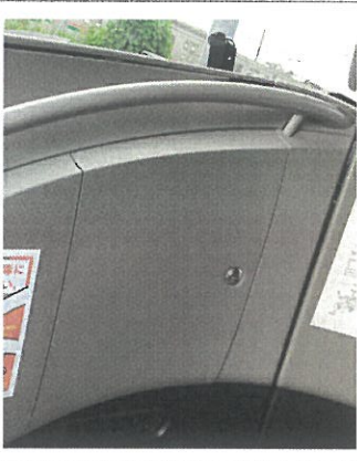
本体取付施工前周辺
