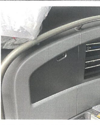
本体取付施工前周辺
