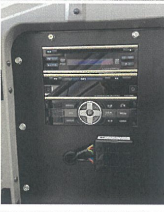
本体取付施工後周辺
