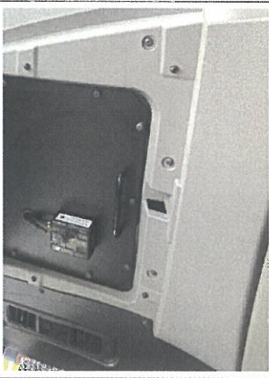
本体取付施工後周辺
