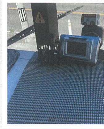
インジゲーター取付写真
