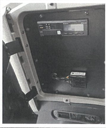
本体取付施工後周辺
